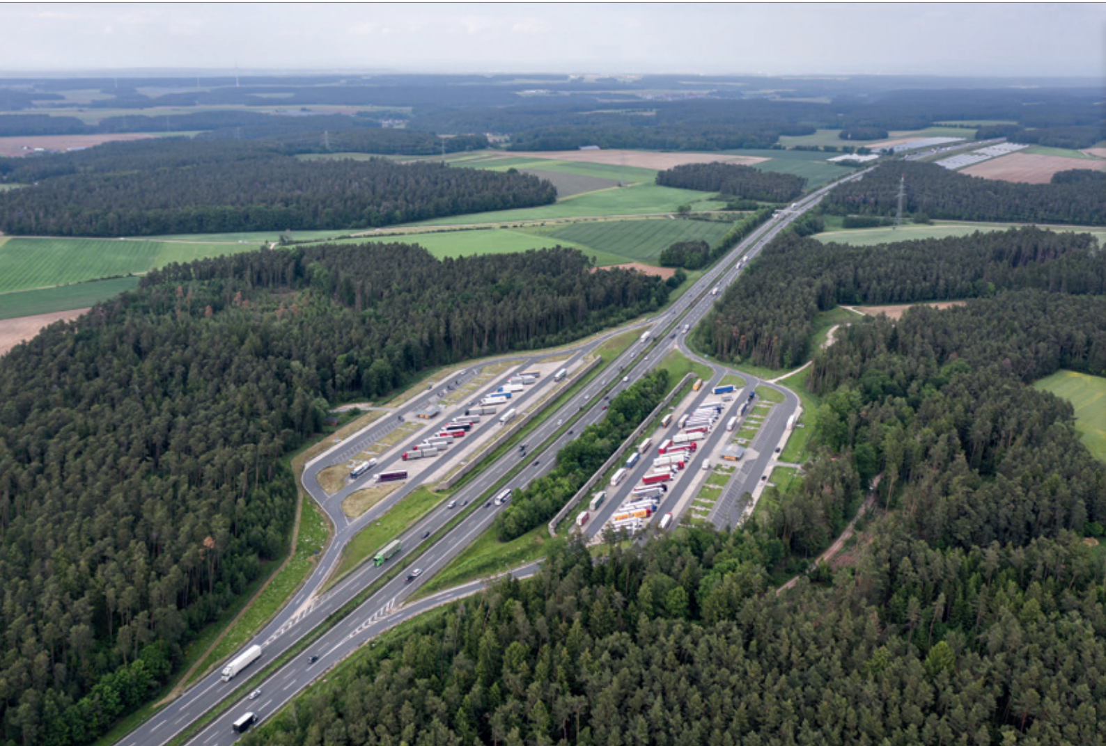
Bild 1: Parkstation Auergründel an der Autobahn A6
