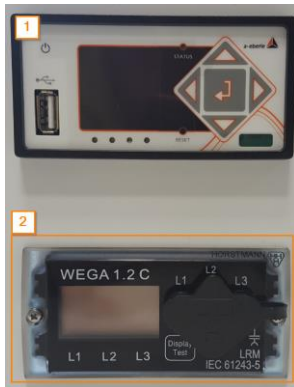
Bild 20: Einbaubeispiel EOR-3D compact und Spannungsabgriff von WEGA 1.2C
