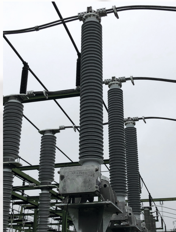
Abbildung 7: Stationäre RC-Teiler zur kontinuierlichen Messung der Power Quality mit PQI-DA smart
